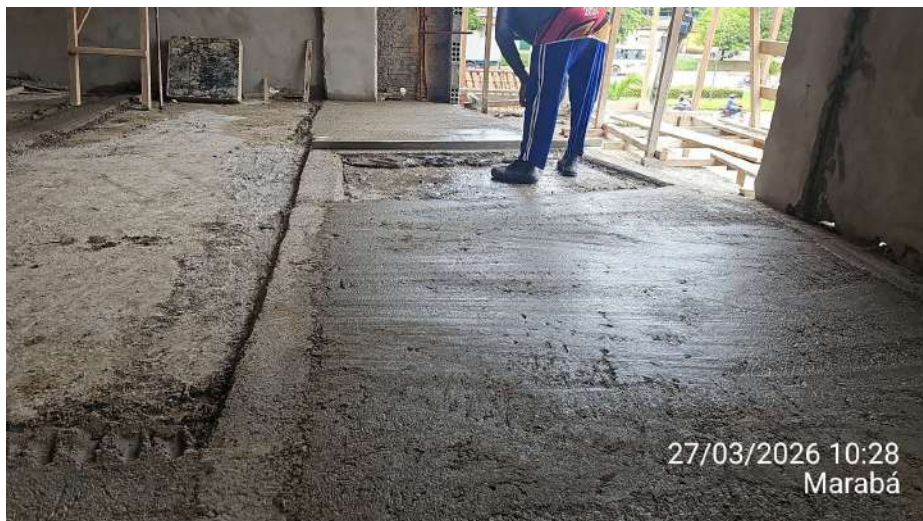
Anexo 02 – Continuação da concretagem do piso de concreto do estacionamento:
