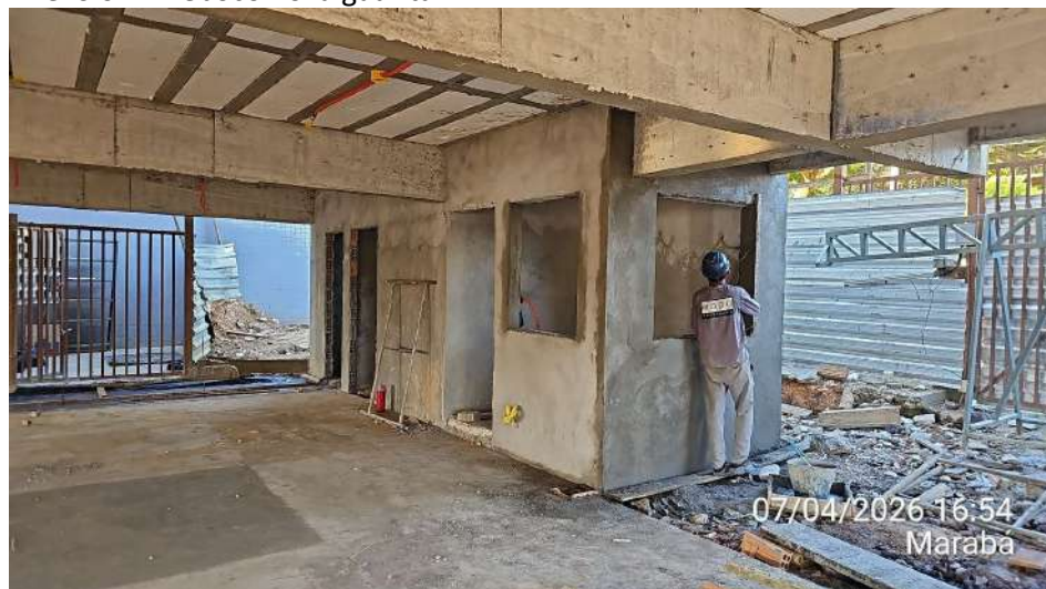
Anexo 02 – Continuação da montagem das fôrmas das vigas do 3º pavimento (cobertura):
