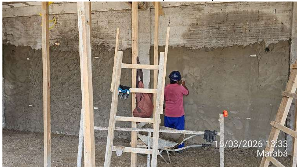
Anexo 01 – Reboco das paredes internas do pavimento superior:
