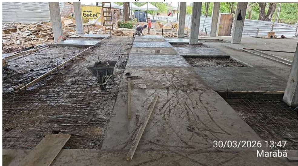
Anexo 02 – Continuação da concretagem do piso de concreto do estacionamento:
