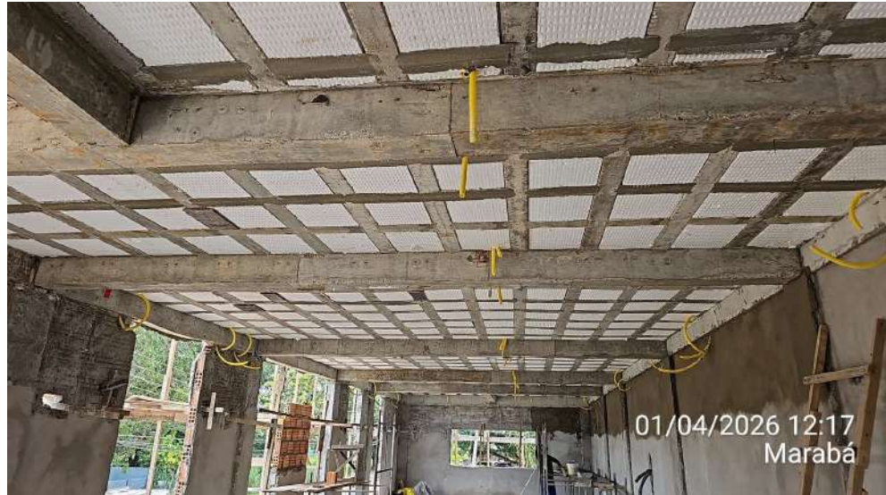
Anexo 01 – Desforma das vigas da laje de cobertura do Anexo 01:
