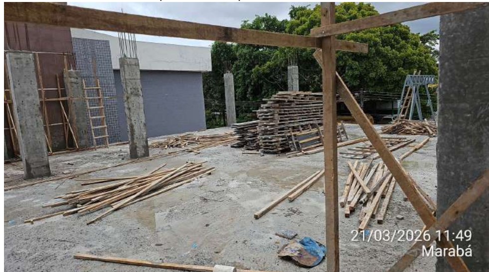
Anexo 02 – Desfôrma dos pilares do 3º pavimento do Anexo 02:
