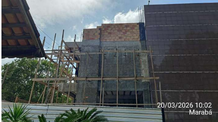
Anexo 01 – Vista frontal da obra e continuação da alvenaria da platibanda:
