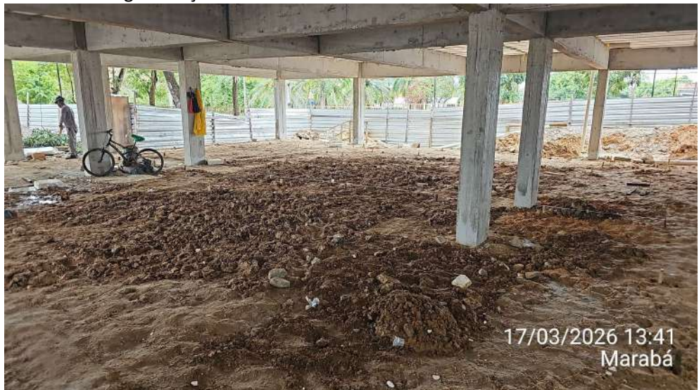
Anexo 02 – Regularização do solo do estacionamento:
