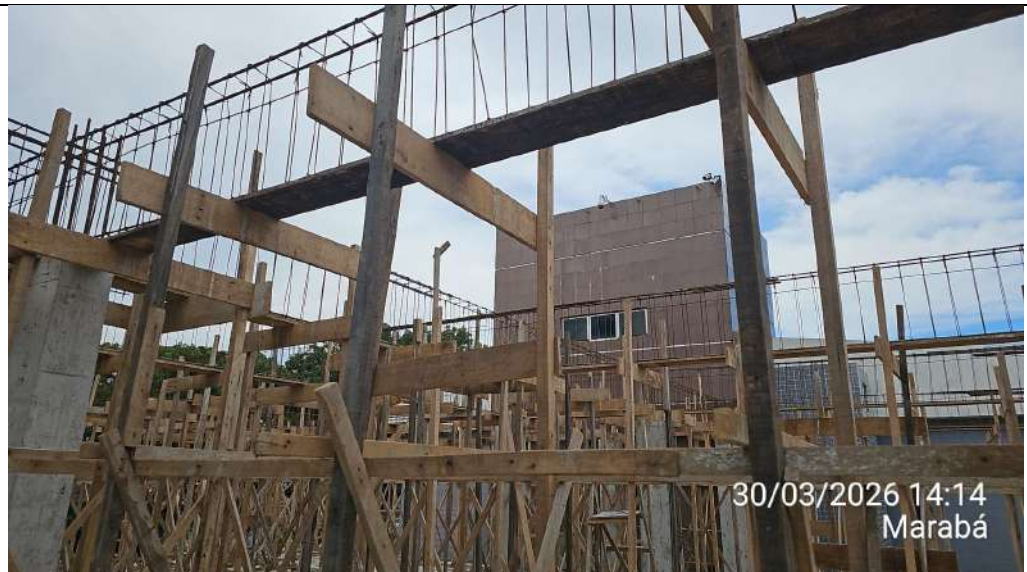
Anexo 01 – Execução de contrapiso do pavimento superior:
