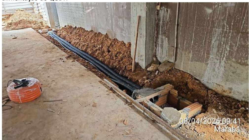
Anexo 02 – Instalação de eletrodutos entre caixas de passagem enterradas para alimentação do QGBT:
