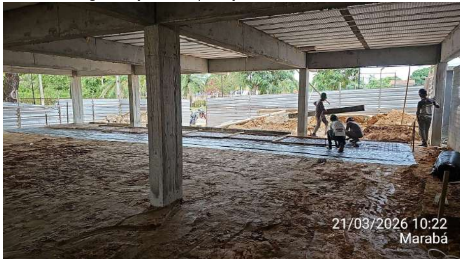
Anexo 02 – Regularização e compactação do solo do estacionamento:
