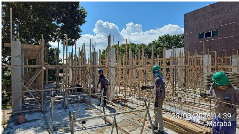
Anexo 02 – Montagem do escoramento e armação das vigas do 3º pavimento do Anexo 02:
