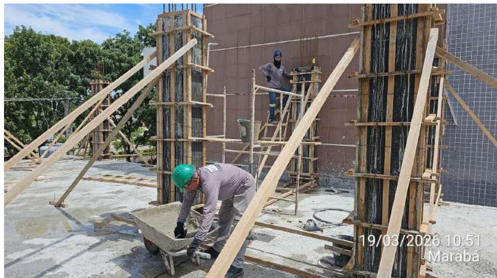
Anexo 01 – Montagem de fôrmas dos pilares da platibanda:
