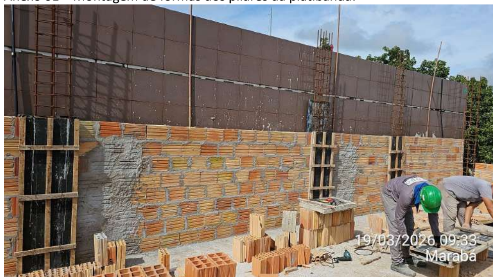
Anexo 01 – Montagem de fôrmas dos pilares da platibanda:
