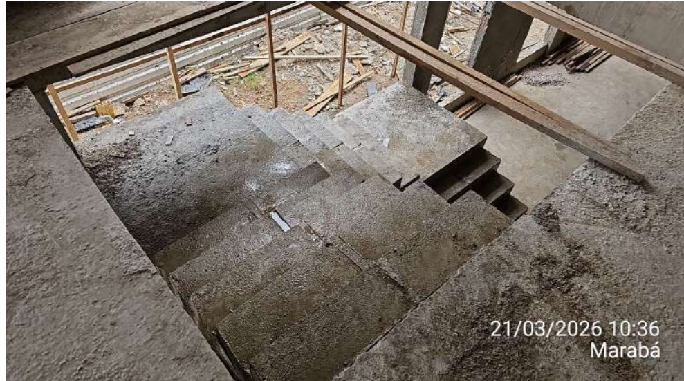
Anexo 01 – Escada concretada e desfôrma lateral.
