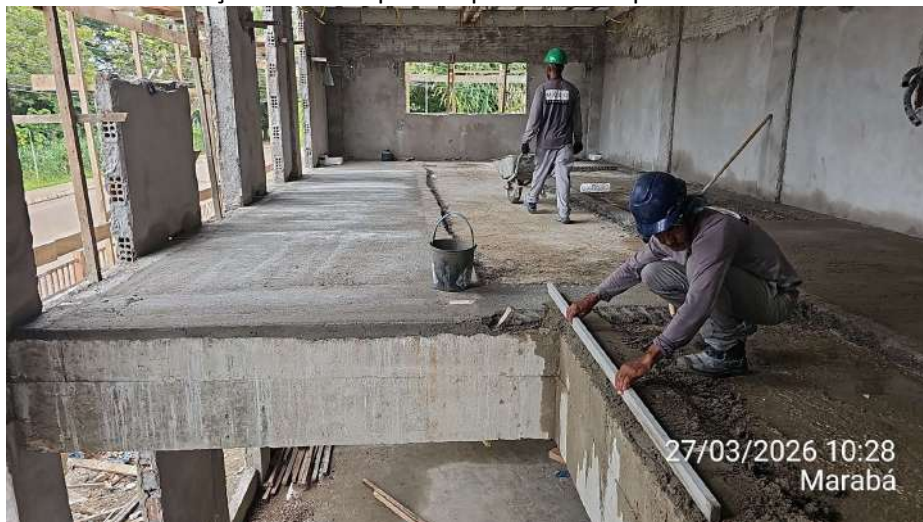
Anexo 01 – Execução de contrapiso do pavimento superior:
